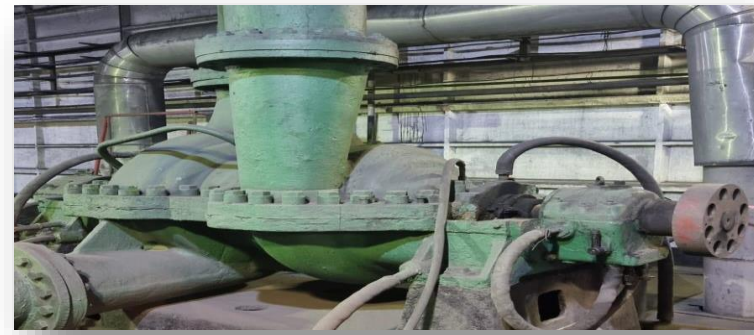
Приобретение и установка насоса ЖВН-12Н 2.88М3/Ч 22КВТ
