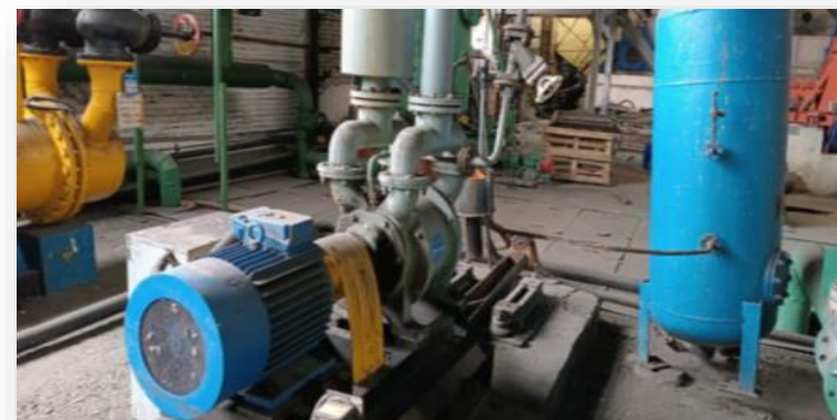
Приобретение и установка насоса ЖВН-12Н 2.88М3/Ч 22КВТ
