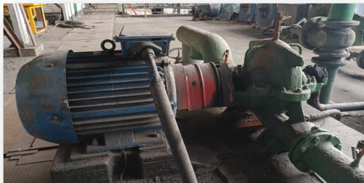
Приобретение и установка насоса Д320-50 с эл.двигателем 75 кВт.
